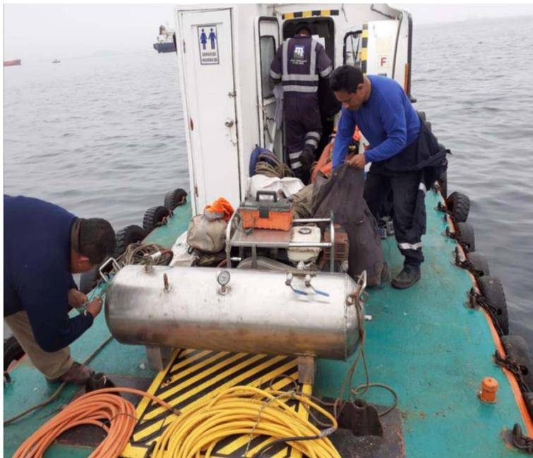
Equipo de apoyo para la instalación del ADCP en el fondo marino.
