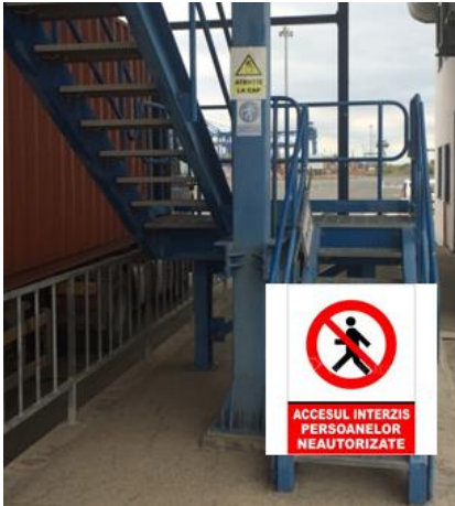
Accesul interzis persoanelor neautorizate pe pasarela de acces peroane Poarta Principala
