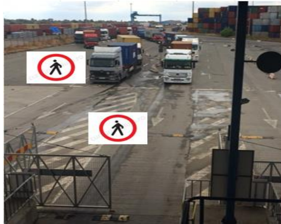
Accesul interzis persoanelor neautorizate in perimetrul zonei persoanelor Portii Principale; interzisa deplasarea pietonala intre zona barierelelor VBS si portile de acces in terminal
